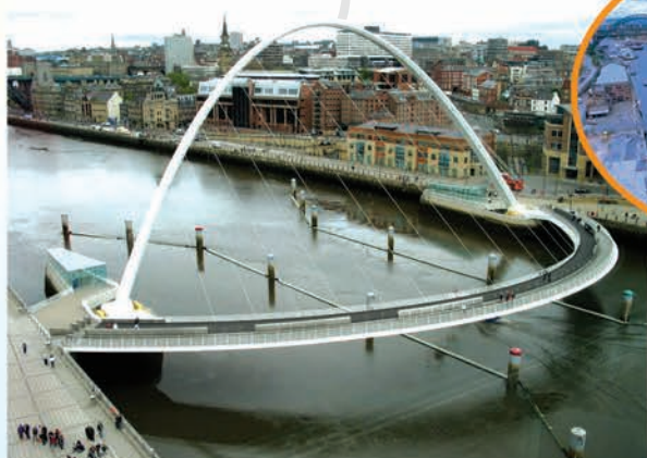
世界上首座旋转式桥梁 ——英国盖茨海德桥
